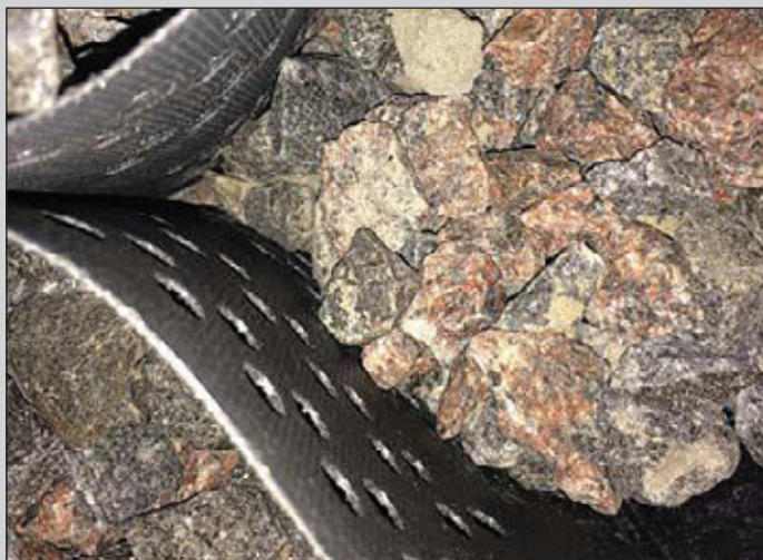
Рис. 5. Заполнение георешетки щебнем фр. 20-40.
