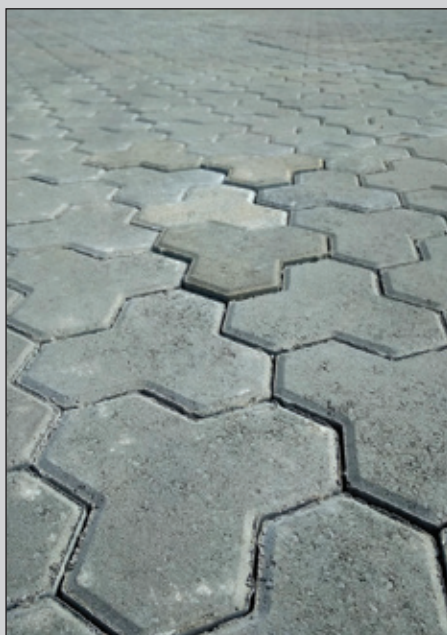
Рис. 8. Гранитный отсев с включением крупных (до 10 мм) зерен щебня явился причиной неравномерной осадки камней мощения.
