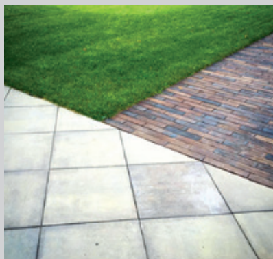
Текстуры покрытий частного участка: свежий газон, бетонные плиты и клинкер ручной формовки. Фото с сайта "СпецПаркДизайн" ( www.spetspark.ru ). Крупноразмерные плиты и вытянутые элементы мощения в моде!
