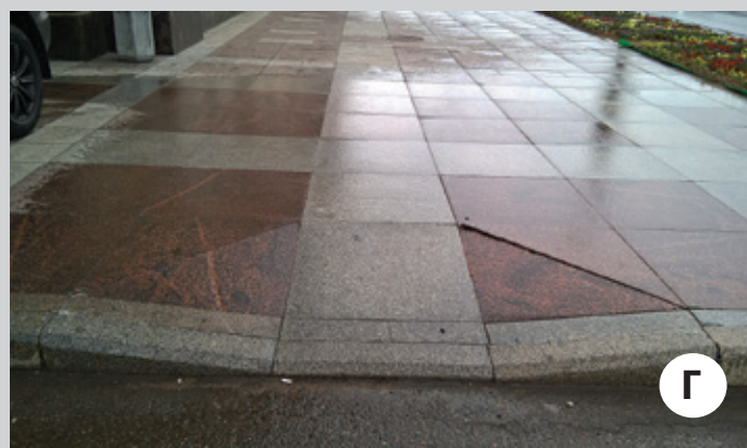
Рис. 5. Экскурсия выявила те же самые проблемы при устройстве покрытий, которые беспокоят представителей индустрии бетонных изделий для мощения: а) камни при укладке не были перемешаны – на покрытии возникают характерные пятна; б) уступы между гранитными плитами – признак некачественного основания; в) скол углов плит – признак недостаточной ширины шва при укладке; г) уступы плит при устройстве понижения – следствие ошибки при проектировании; для выполнения понижения в данной ситуации предпочтительно использовать мелкоштучные брусчатые камни.
