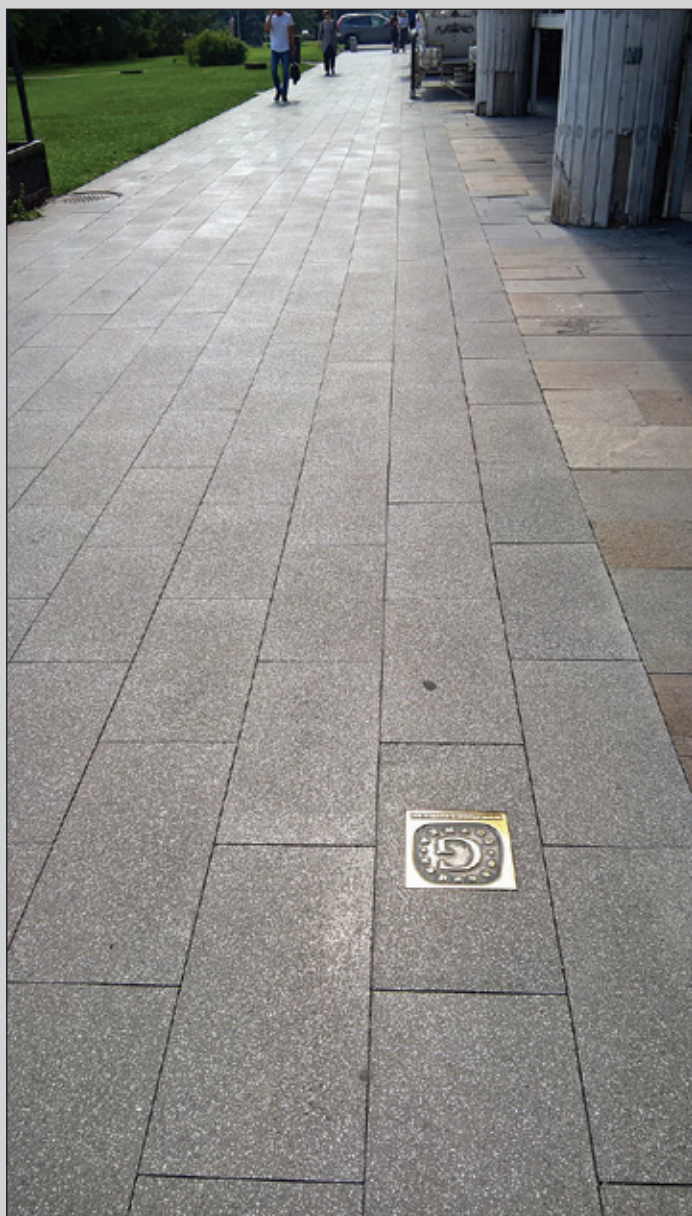
Рис. 3. Бетонные плиты “под гранит”. Государственная Третьяковская галерея. Москва.
