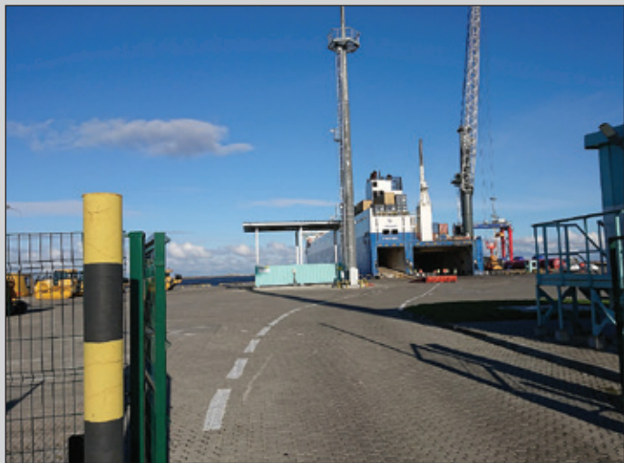
Рис. 9. Мощение на территории порта Бронка. 4 года эксплуатации.
