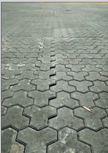
Рис. 8. Гранитный отсев с включением крупных (до 10 мм) зерен щебня явился причиной неравномерной осадки камней мощения.
