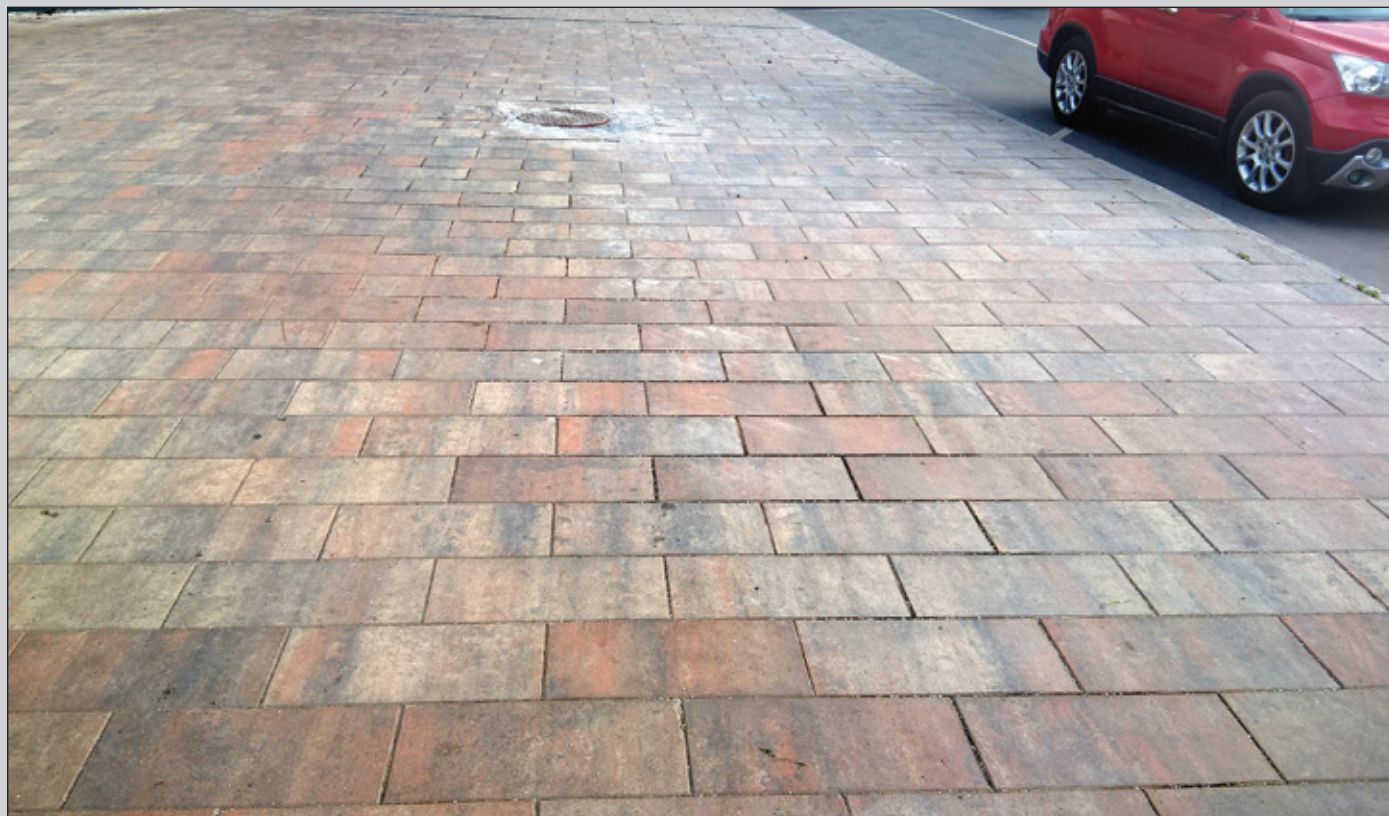
Рис. 1. Плиты размером в плане 600x300 мм стали очень популярными в мощении. Тротуар в Москве.
