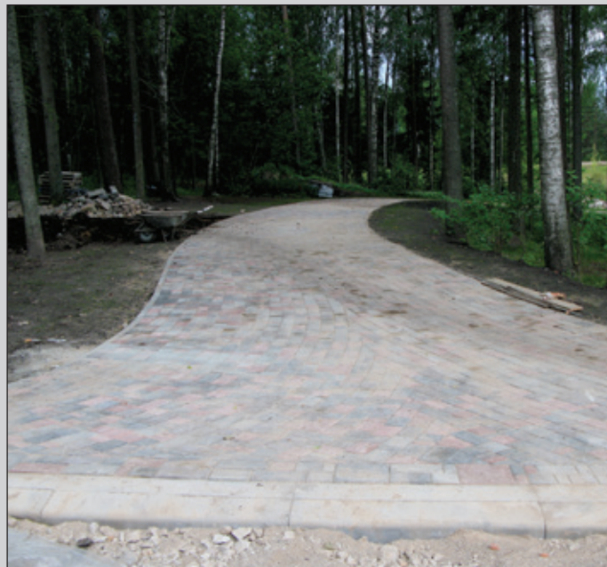
Высолы на поверхности мощения возникают не только в России. На фото - дорога в элитном коттеджном поселке в Латвии.
