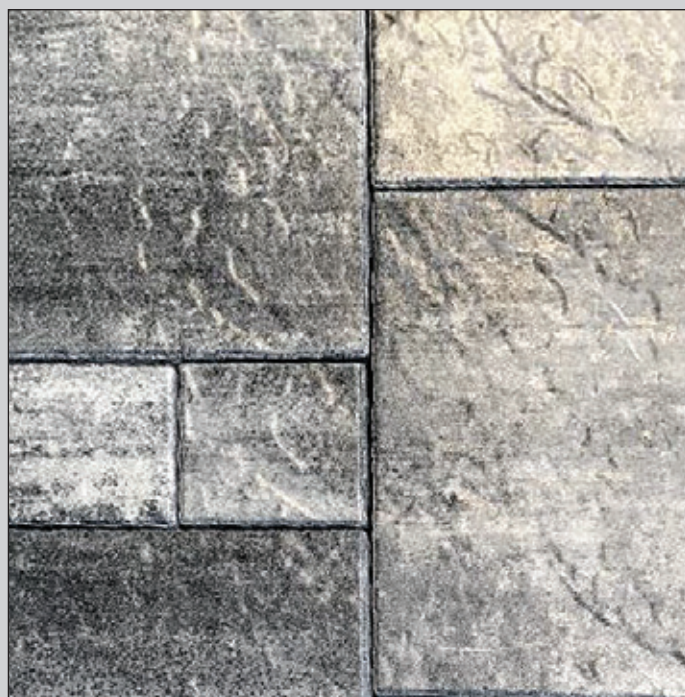
Рис. 5. Нанесение специальных покрытий предотвращает появление высолов, создаёт эффект яркого очного цвета; обработанная плитка в меньшей степени подвержена загрязнению.
