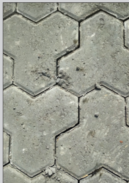
Рис. 8. Гранитный отсев с включением крупных (до 10 мм) зерен щебня явился причиной неравномерной осадки камней мощения.
