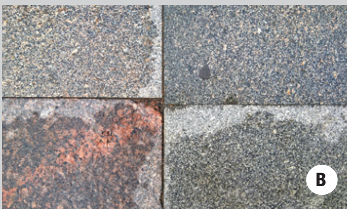
Рис. 5. Экскурсия выявила те же самые проблемы при устройстве покрытий, которые беспокоят представителей индустрии бетонных изделий для мощения: а) камни при укладке не были перемешаны – на покрытии возникают характерные пятна; б) уступы между гранитными плитами – признак некачественного основания; в) скол углов плит – признак недостаточной ширины шва при укладке; г) уступы плит при устройстве понижения – следствие ошибки при проектировании; для выполнения понижения в данной ситуации предпочтительно использовать мелкоштучные брусчатые камни.
