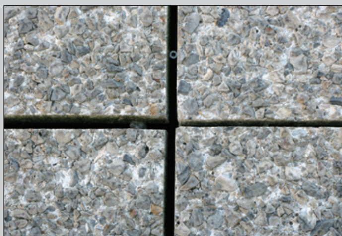
Рис. 2. Плиты размером в плане 1000x1000 мм в покрытии эксплуатируемой кровли. Париж. Район Сити (а). Вид лицевой поверхности (б).
