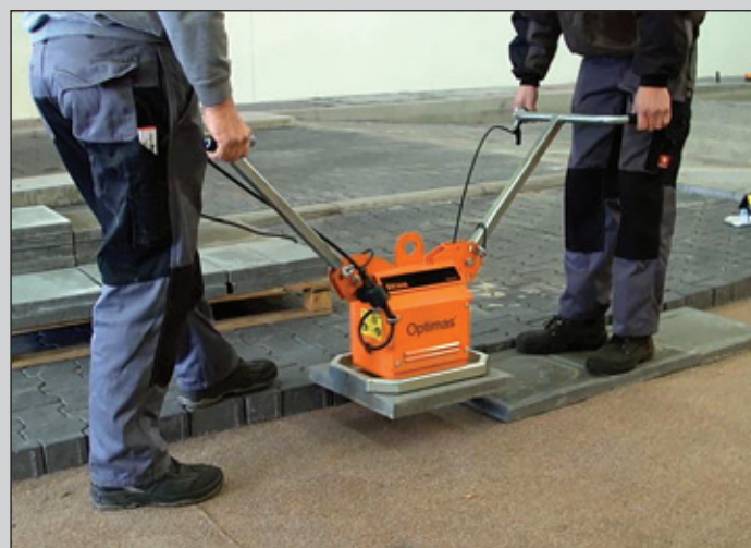
Рис. 5. Использование вакуумных захватов для укладки плит.
